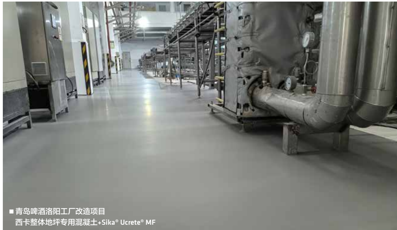
■ 青岛啤酒洛阳工厂改造项目 西卡整体地坪专用混凝土+Sika® Ucrete® MF
